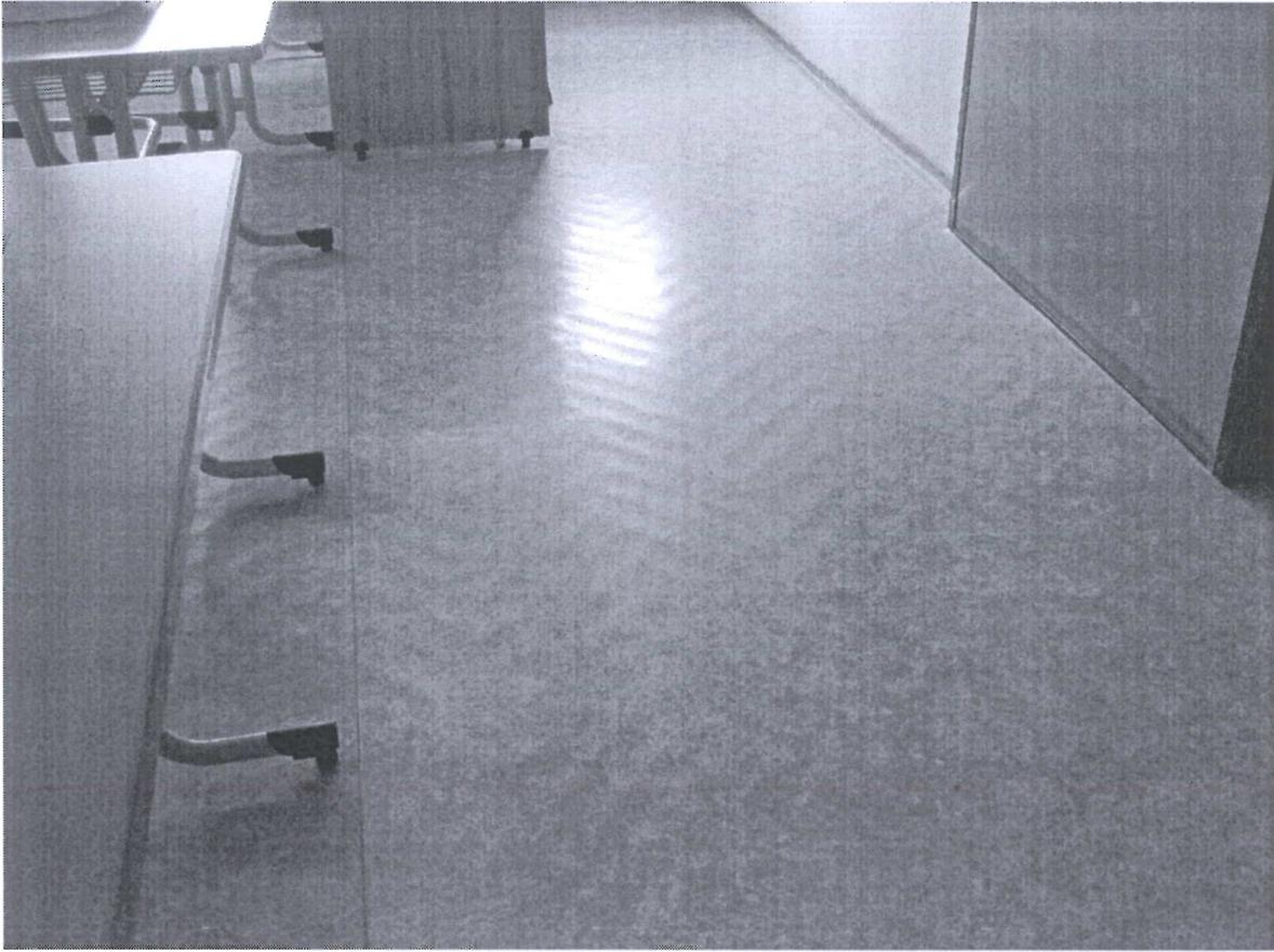
po odstranění PVC nutno provést nivelaci -požaduje se vyrovnání podkladu podlah tříd před pokládkou nové povlakové krytiny do normových hodnot - +-2mm na dvoumetrové lati! Proto jsou nivelační stěrky navrženy ve dvou vrstvách.
